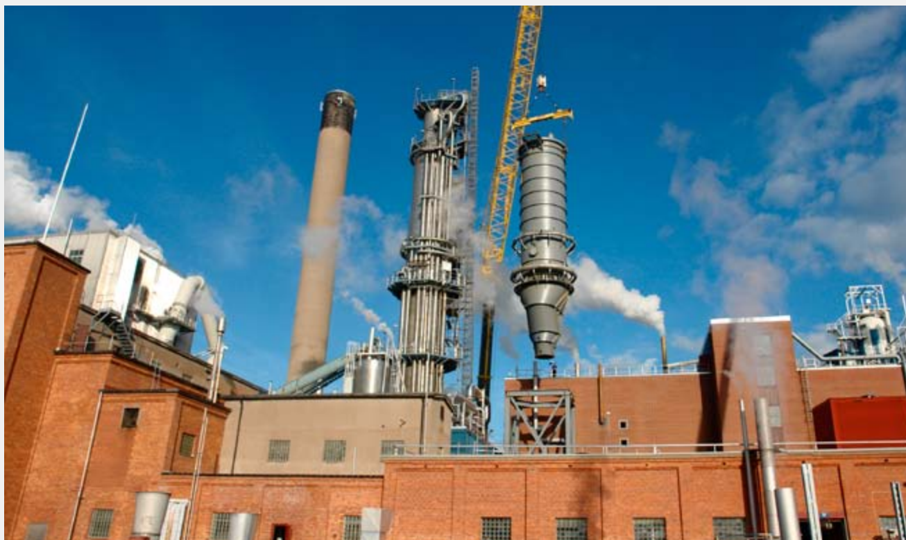
Installation av förbäsningfickan vid Aspa bruk.
